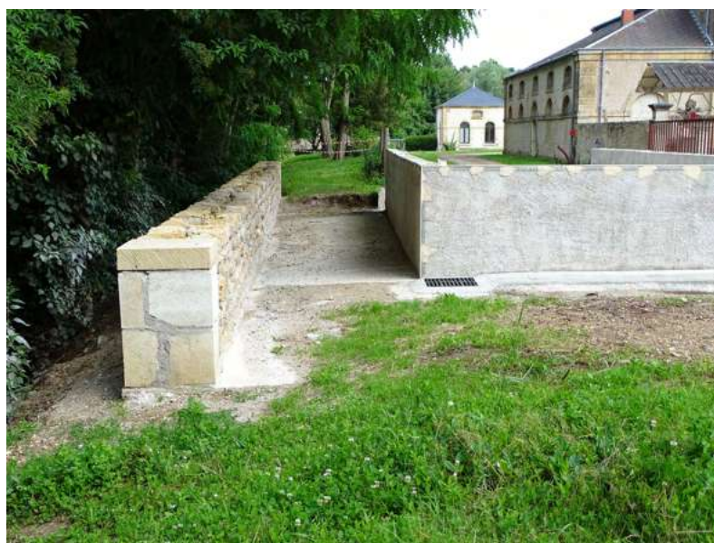
Réalisation par la section maçonnerie FOREPABE
