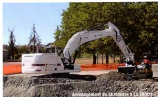
Aménagement du skatepark à La Châtre
