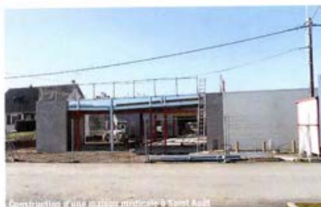
Construction d'une maison médicale à Saint Aulst
